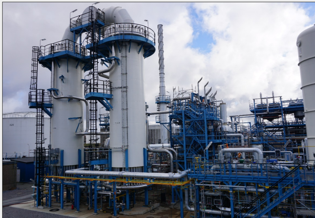
Raffinaderiets nya anläggning för produktion av vätgas.
