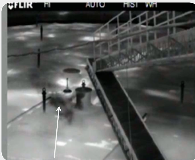
Läcksökning med hjälp av FLIR-kamera
